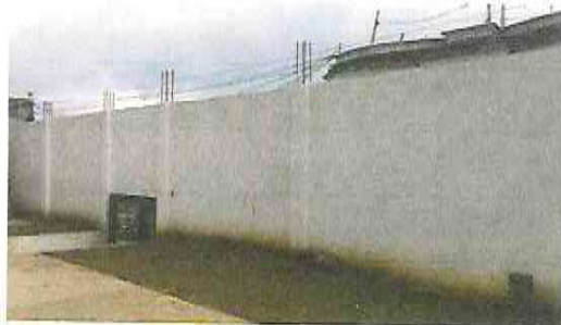
Foto 5: Paredón reparado, vista parte interior
