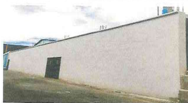
Foto 2: Muro perimetral reparado, vista de Norte hacia Sur.
