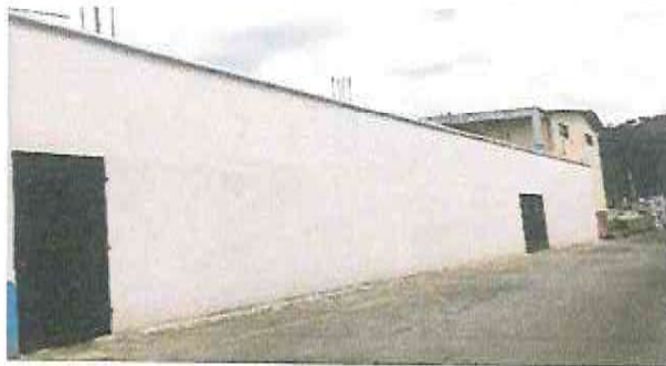
Foto 1: Muro perimetral reparado, vista de Sur hacia Norte.
